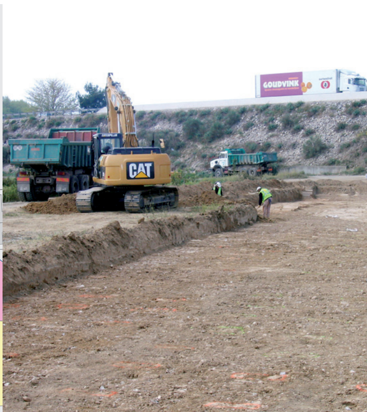
Le site en cours de décapage au pied de l'autoroute A9 © Cécile Dominguez, Inrap
