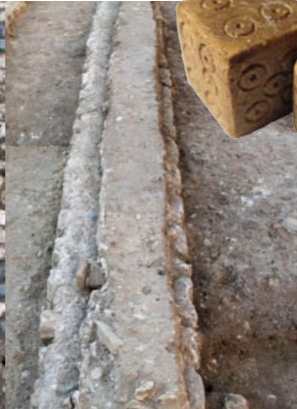
Cloison de terre surmontant un mur bahut © Inrap
