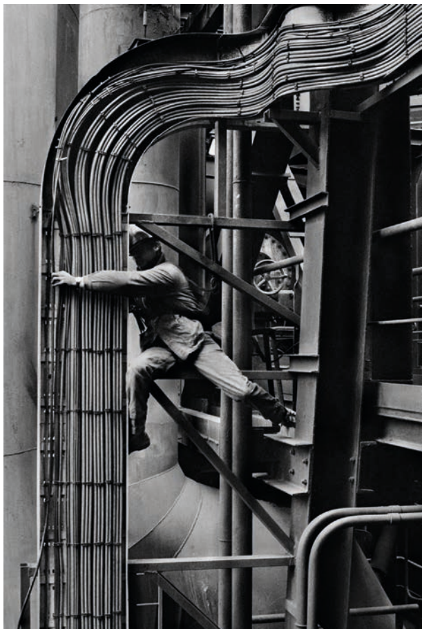
Un ouvrier répare des tuyaux qui font partie du système de câblage électronique autour du haut-fourneau numéro 4. Dunkerque. France, 1987. © Sebastião Salgado
