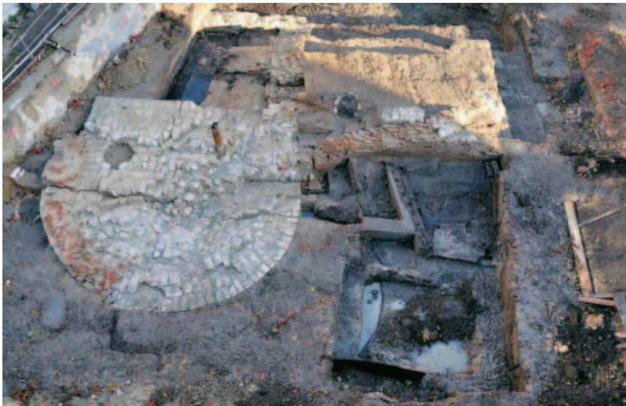
Le radier de fondation en aulne de la tour de l'Angèle, vu du sud. Au premier plan, la fosse d'installation de la tour dont les parois sont soutenues par un batardeau clayonné. En arrière-plan à gauche, le reste du rempart en briques et le premier état de la tour en craie et en grès.
