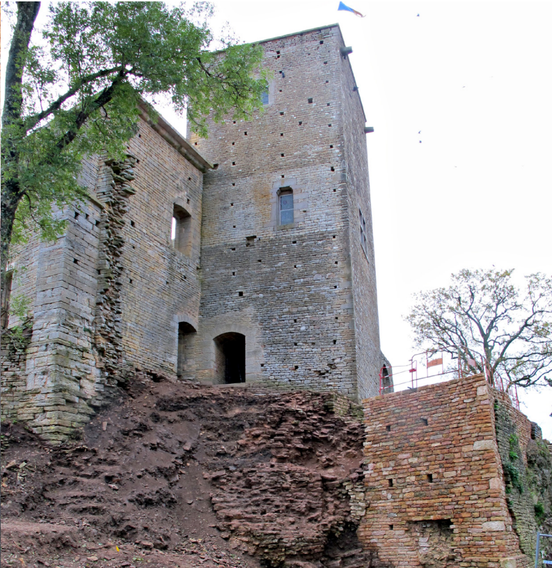
Partie supérieure du talus nord de la butte, avec étagement des maçonneries des X e -XI e siècles en cours de dégagement, donjon du XII e siècle en élévation, et appui du grand logis ducal du début du XIV e siècle © Benjamin Saint-Jean Vitus, Inrap
