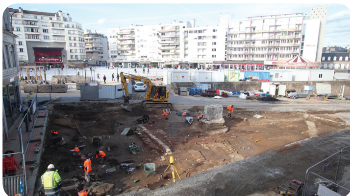
Le site en cours de décapage et la place de la République en arrière-plan © Patrick Ernaux, Inrap
