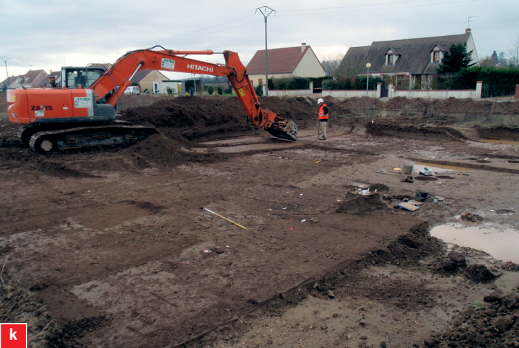
k - Extension de décapage à la pelle mécanique lors du diagnostic de la Rue des Sentes en 2009 pour mettre au jour l'intégralité du plan d'une construction sur poteaux plantés de la fin de l'Antiquité.
