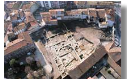
Chantier de fouilles à Toulouse.
