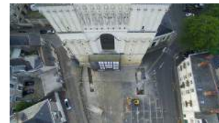
Vue des sondages réalisés sur le parvis de la cathédrale d'Angers © ICOPTAIR 2016
