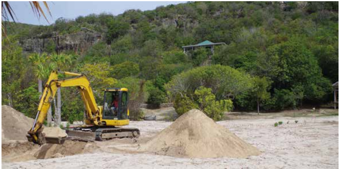
Sondages à la pelle mécanique sur le site de l'Anse du Gouverneur à Saint-Barthélemy. Ils ont révélé des vestiges précolombiens de deux foyers et des rejets de consommation de coquillages issus probablement d'un campement de bord de mer daté du Néoindien récent (1000-1492).
