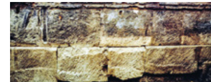
Le libage (fondations) est fait de blocs de calcaire dur local. Certains ont été récupérés sur des bâtiments publics extra-muros détruits afin de créer le glacis défensif. Ci-dessous, élément de corniche découvert à la base d'une des tours de l'enceinte. © Joseph Guilleux
