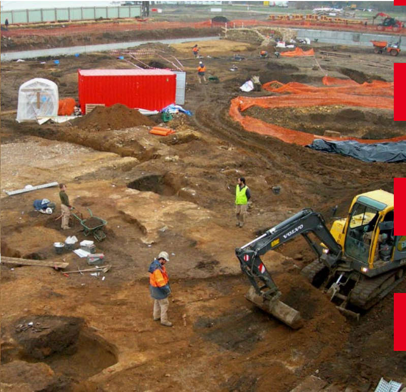
Vue d'ensemble du chantier
