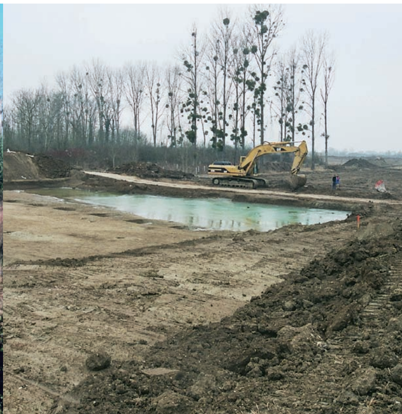
Les travaux de franchissement du ruisseau pendant l'hiver 2005-2006 ont permis de découvrir son lit naturel, à quelques dizaines de mètres de son tracé actuel © Inrap
