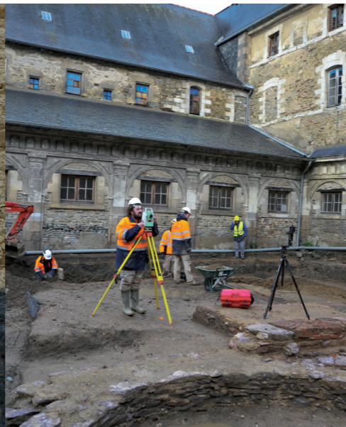
Levé topographique avec une station totale (Rennes, Ille-et-Vilaine, 2012) © Hervé Patier, Inrap
