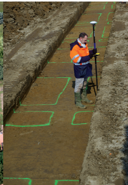
Levé topographique au GPS différentiel (Borre, Nord, 2013) © Denis Gaillard
