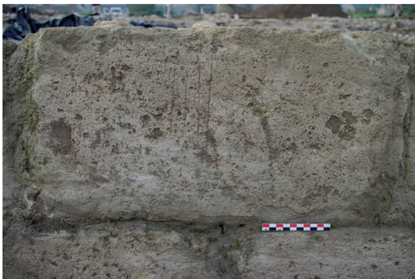
Cl. 163 Détail d'une des traces lapidaires, blocs de M2039
