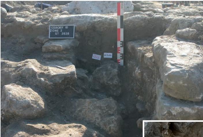
CI.193 Détail du conduit du caniveau 2828 obstrué et comblé Louis Hugonnier
