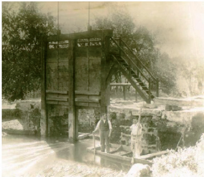
Fig. 185 Deux exemples de martellières © http://patrimoine-de-france.com/ pour Condac et http://salins.com/ pour Hyères-les-Palmiers
