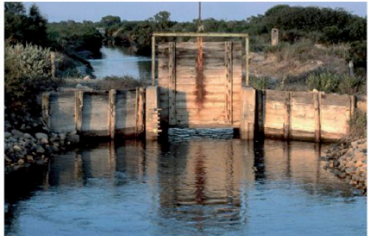
Martellière sur l'ancien marais salant dit les salins d'Hyères, commune de Hyères-les-Palmiers
