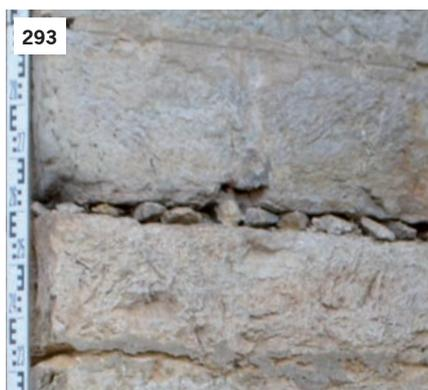
**Fig. 293** : Chapelle Saint-Louis, détail d'un joint de mortier dégradé par l'eau des drains. On distingue très bien les petits cailloux de réglage entre les assises.
