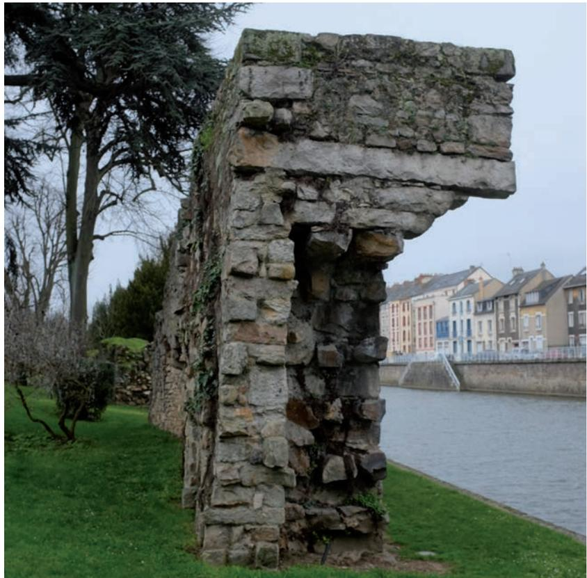
L'usage des terres extraites du fossé comme liant de maçonnerie est avéré par les sources textuelles à Tours. À la vue des mortiers des courtines, la question se pose effectivement si cette méthode n'a pas été employée et est à l'origine de la friabilité des liants des deux maçonneries (des prélèvements ont été réalisés mais non étudiés).
