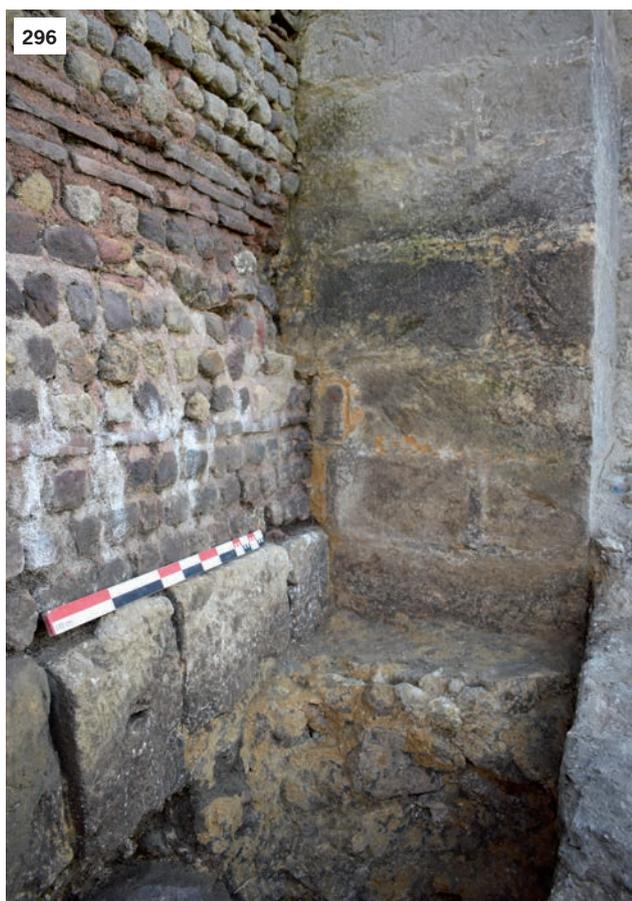
**Fig. 296** : Semelle de fondation (US2450) au niveau de la jonction entre la chapelle Saint-Michel (travée III) et la courtine romaine.
