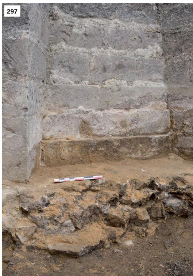
**Fig. 297** : Semelle de fondation (US 2450) et soubassement en gradin (US 2700) au niveau de la travée III de la chapelle Saint-Michel.
