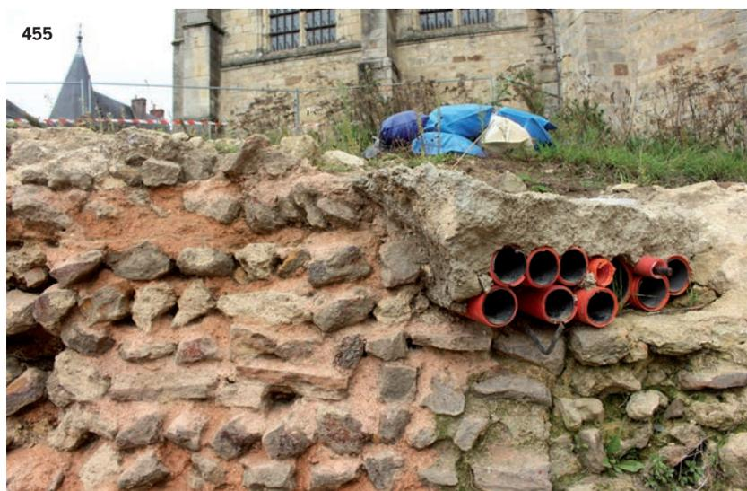
**Fig. 454** : Réseau de câbles électriques divers autour de la cathédrale.
