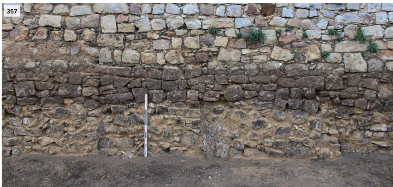
**Fig. 357** : Fouille de la place du Jet d'eau, 2016. Détail des fondations dégagées du mur d'enceinte.
